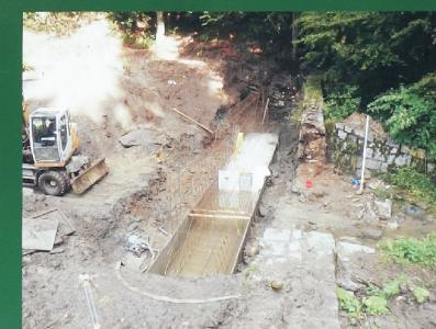
Součástí oprav bylo vybourání stávající poškozené přehrádky v délce 8,243 a výstavba nové retenční přehrádky za účelem zachycení a usazování splavenin a plavenin. Retenční prostor cca 2150 m<sup>3</sup>, výška přepadové hrany tělesa přehrádky 2,5 m, šířka 32 m. Průtočnost přelivu – Q 20, kapacita průtočného otvoru
