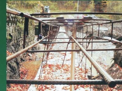
s průjezdnými otvory – Q2-Q5. Konstrukce přehrádky je z vodostavěbního využitelného betonu s obkladem zdí z lomového kamene na MC 100 s vyspárováním záclíní i rubové strany. Stavba dokončena v 11/2013.
